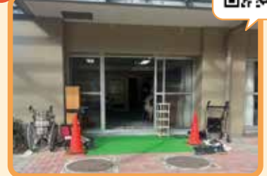
13 敷津東住宅集会所
